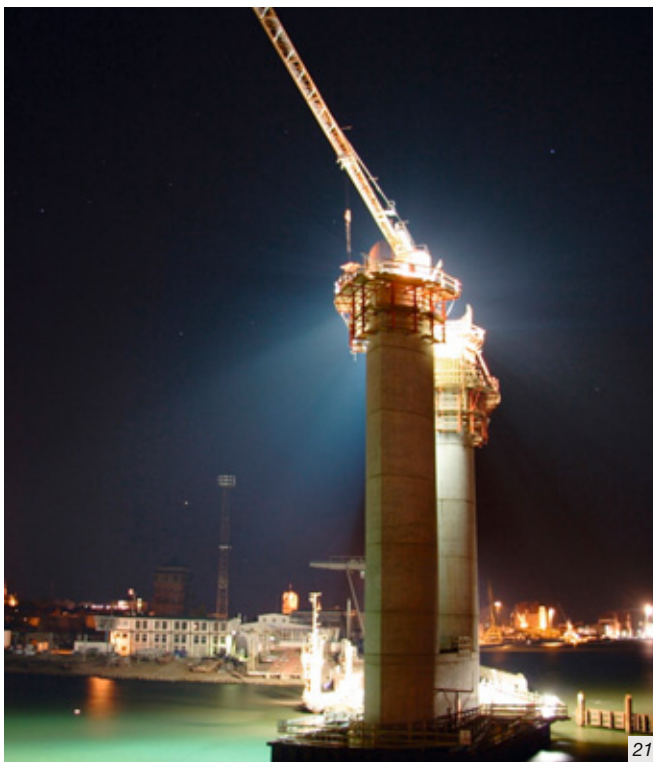
Bei Arbeiten mit Kränen ist zugleich auf gute Sehbedingungen des Kranführers wie des Personals am Arbeitsort zu achten.
