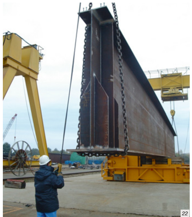
Bei Arbeiten mit Kränen ist zugleich auf gute Sehbedingungen des Kranführers wie des Personals am Arbeitsort zu achten.
